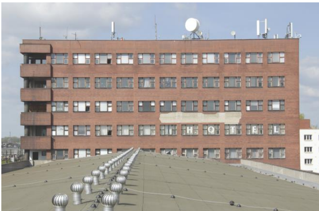
- - Obr. 5 – pohled na výškovou část s již odpadanou fasádou (obkladovými pásky)
