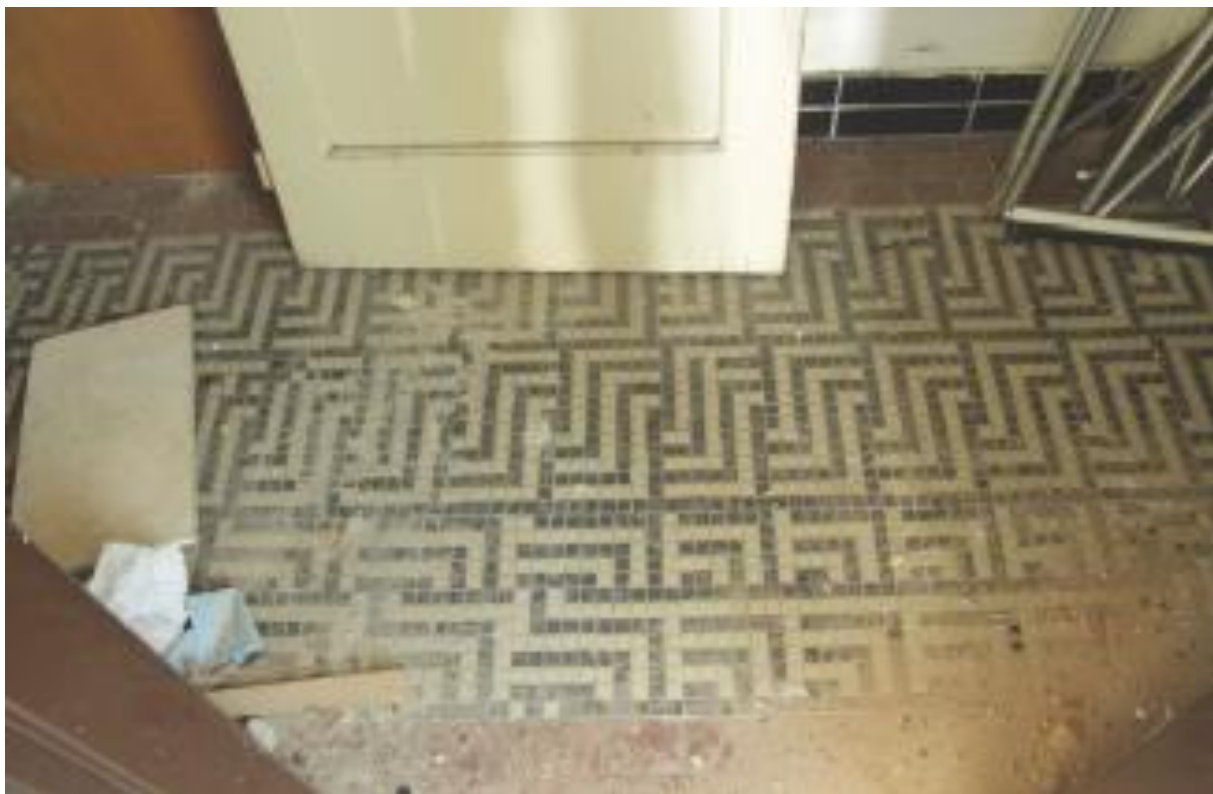
- - Obr. 10 – detail podlahových mozaikových dlažeb – provádění replik a restaurování
